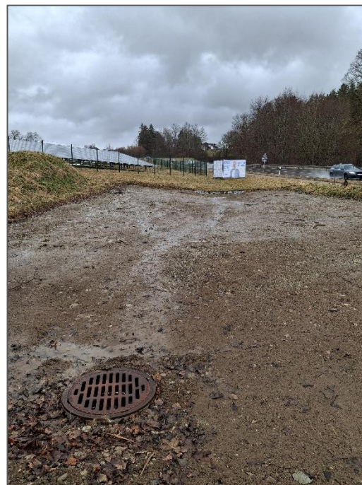
Abbildung 14: Abflussschacht im östlichen Änderungsbereich
